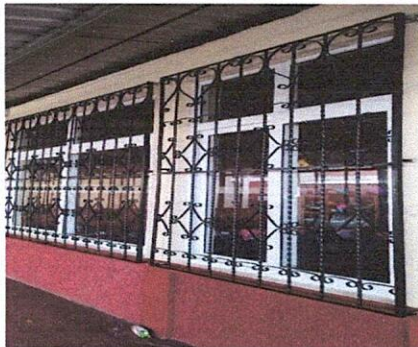
Foto 3: Despues, finalización de ventanas correrizas para mejor ventilación
