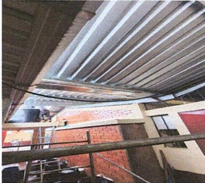
Foto 3: Despues, finalización del cambio de láminas por donde se encuentra lavamanos,
