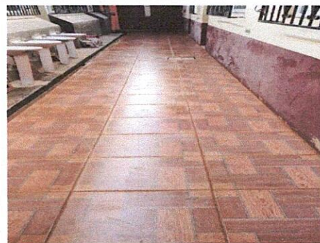
Foto 3: Despues, finalización de colocación de piso de loza corredor.
