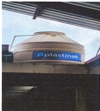
Foto3: Despues, instalacion del nuevo Tinaco.
