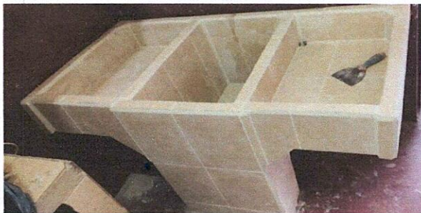
Foto 3: Despues, finalización del azulejado de pila 2.
